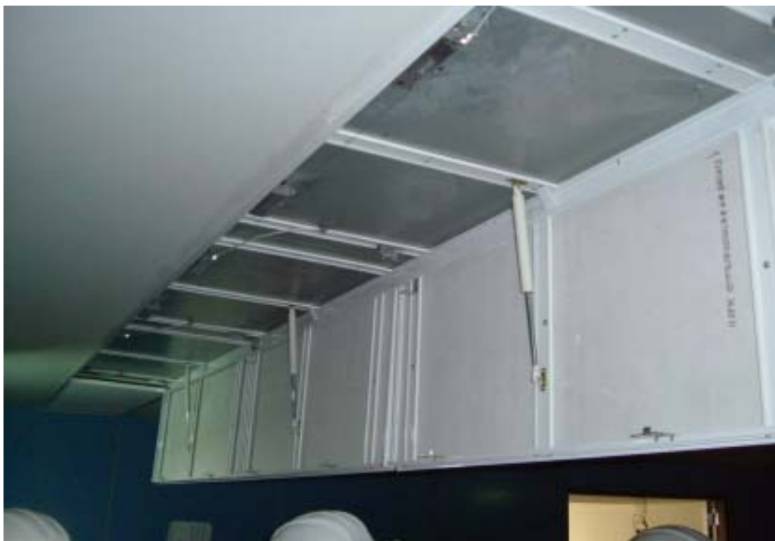
圖 2.50 可動式防煙壁
