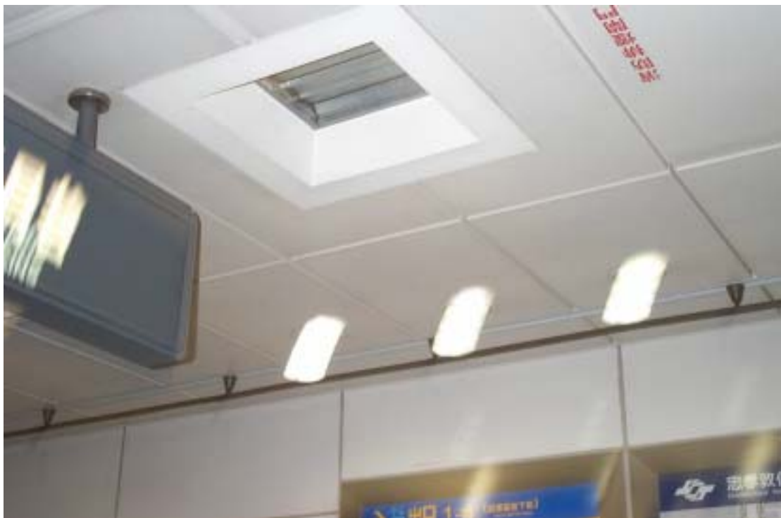
圖 2.53 多葉片式排煙口
