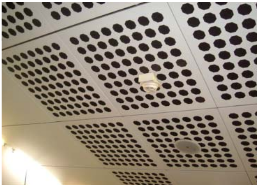
圖 7.4 斜式天花板之火警探測器安裝
