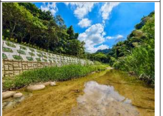
圖號8 單岸預鑄基礎設計避免棲地擾動
