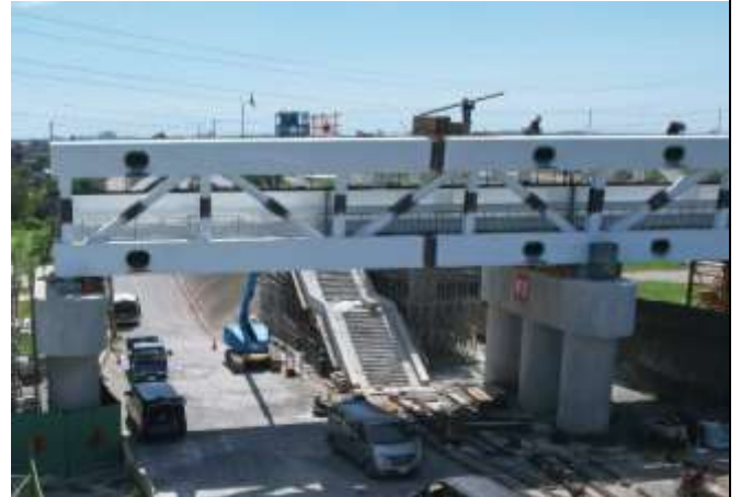
圖號6 桁架簍空設計保留生物通透性
