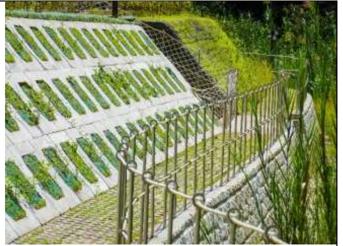
圖號4 護坡多孔隙材質設計
