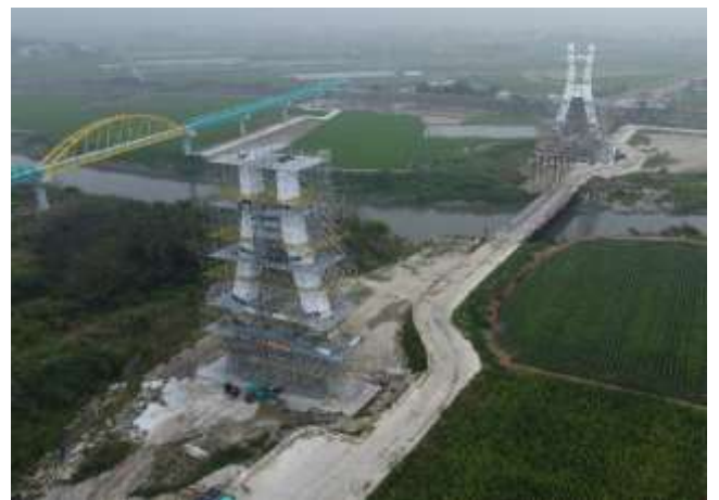
圖號4 吊掛組裝縮減施工使用空間
