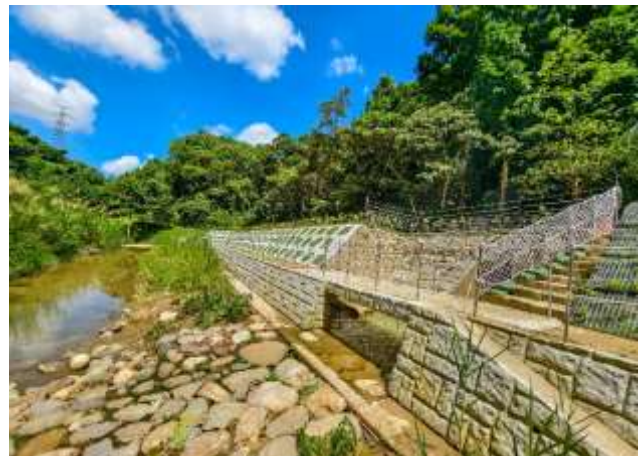
圖號2 主支流銜接處多樣式生物通道
