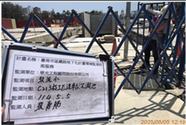
圖13-工區放流水監測
