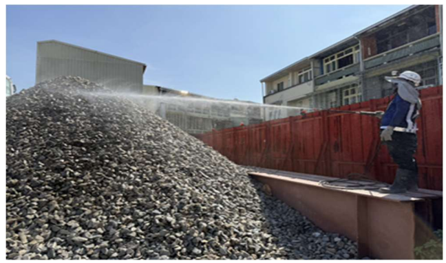
圖2-工區道渣灑水
