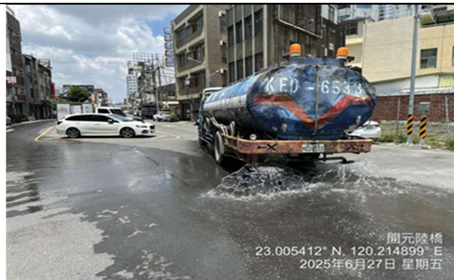
圖4-工地周邊灑水清潔道路
