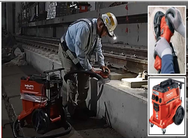
圖21-隧道內使用集塵研磨系統
