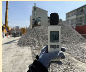
工區周邊噪音檢測
