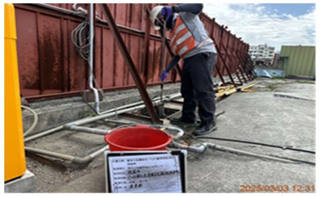
圖10-工區放流水監測
