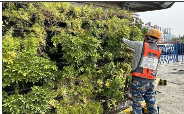
圖3-工區周邊綠美化環境整理
