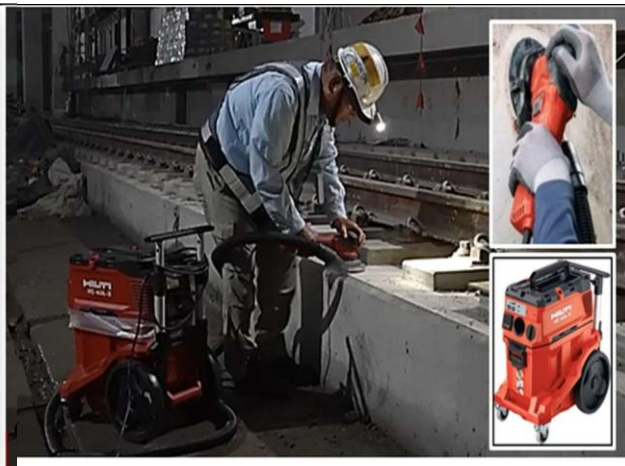
圖21-隧道內使用集塵研磨系統
