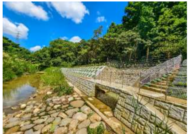
圖號2 主支流銜接處多樣式生物通道
