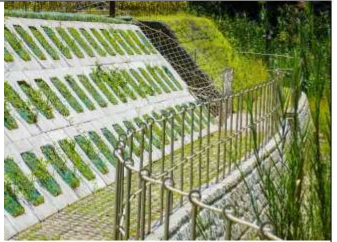
圖號4 護坡多孔隙材質設計
