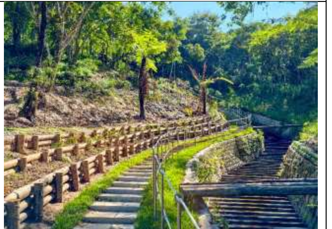
圖號6 坡面緩坡、多樣式生態通道設計及原生樹蕨保存等
