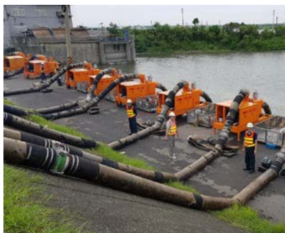
大型移動式抽水機
