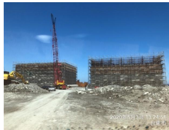
沉箱製作情形
