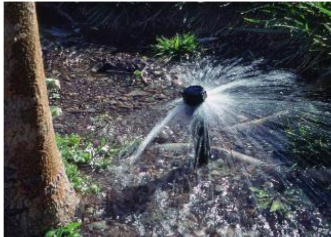
圖 4-14 噴灌水量過大，且太靠近樹幹基部，容易有積水、增加感染疫病及根腐的機會。(ISA 提供)
