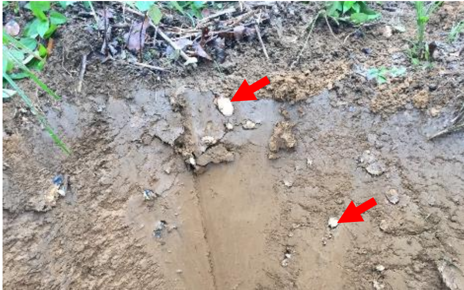
圖 4-6 斷根後須注意切根平整度。
