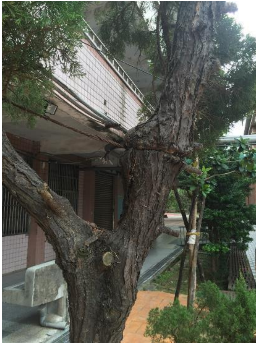
圖 5-19 支撐桿或鋼纜需定期檢查並進行調整，避免傷害樹木。
