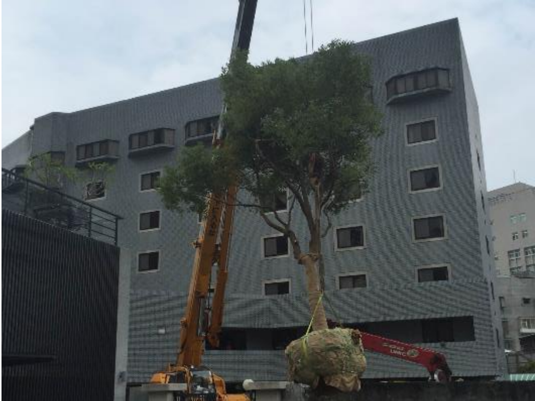
圖 4-15 吊運前為方便調整樹體角度，可於不影響吊運點處加裝繩索。
