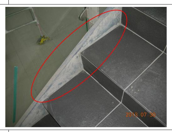
**說明** 圖書館內部樓梯 1 樓至 2 樓處鋼板,有混凝土污損。
