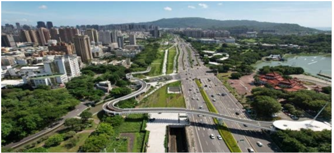
土木類特優-「高雄市區鐵路地下化園道開闢工程-左營計畫」 -崇德路至華榮路
